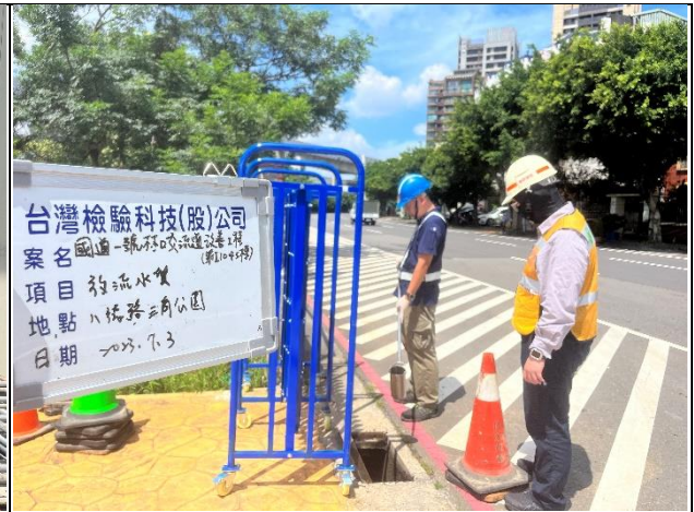
監測項目：放流水質 監測日期：2023.07.03 監測地點：八德路三角公園
